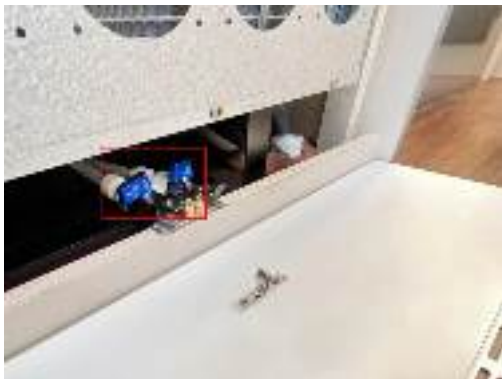
管路排空阀位置
