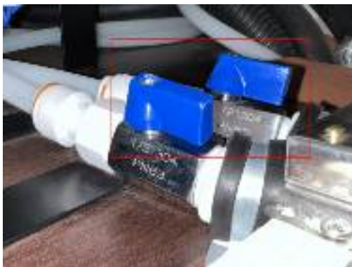
管路排空阀开启方向
